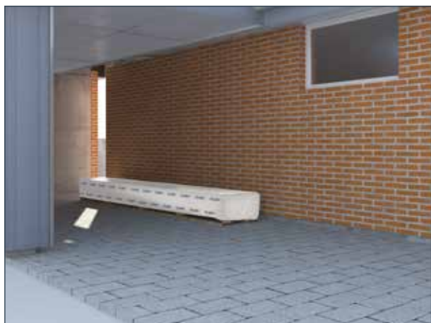
Om materialen lagras på byggarbetsplatsen i mer än 2-3 veckor ska produkten förvaras under tak. Högst 2 Panel pallar eller 4 Plank pallar kan staplas ovanpå varandra.
